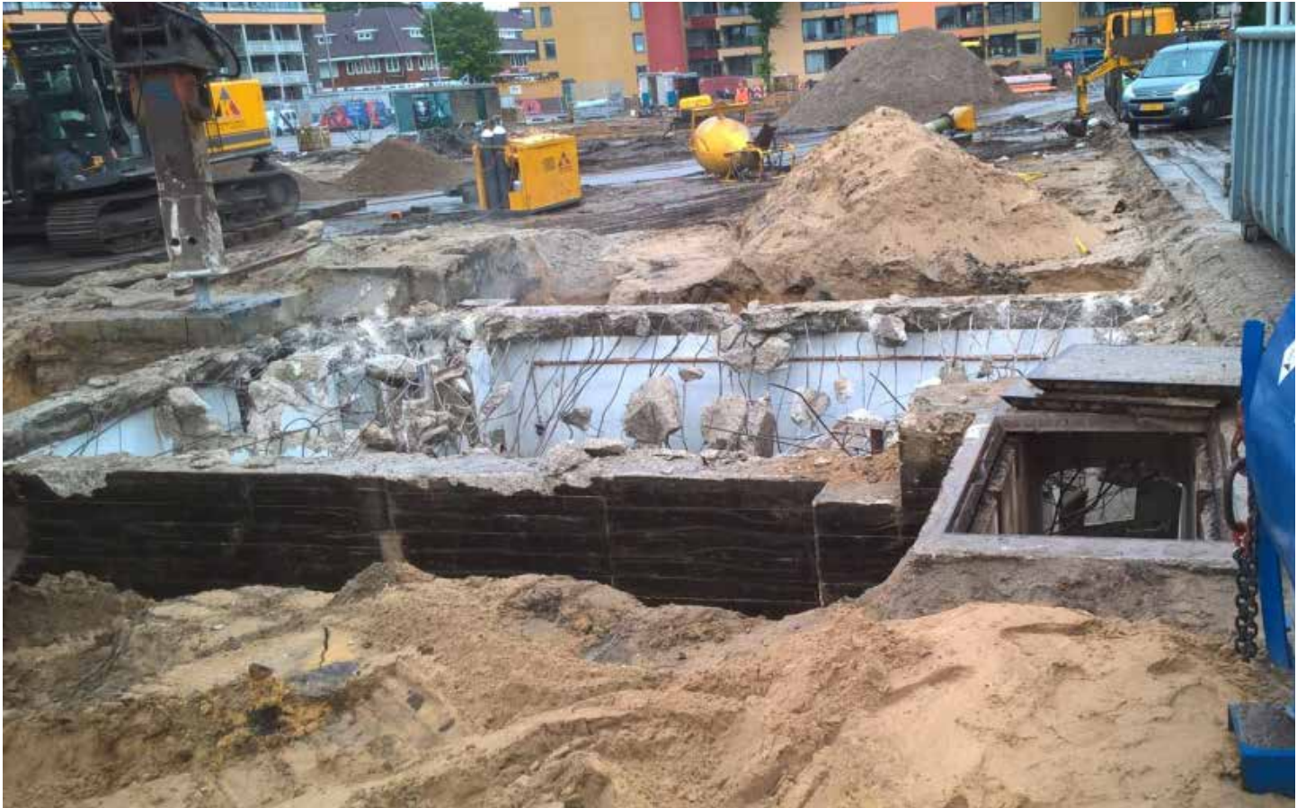
Afbeelding 46: de atoomschuikelder onder het Langgewenst, ontdekt en blootgelegd tijdens de herinrichting van het Langgewenst in 2016. De schuikelder is uiteindelijk geheel afgebroken en verwijderd. Een deur van de schuikelder is nog behouden gebleven en elders opgeslagen. Foto: Struijk Sloop- en Grondwerken Nederland B.V. Foto geplaatst met vriendelijke toestemming van C. van Hartingsveldt, Struijk.
